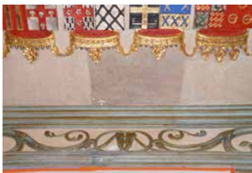
Nettoyage du plafond du petit hall (zone centrale non nettoyée).
