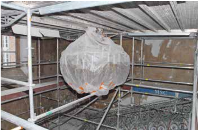
Vue de l'escalier d'honneur pendant les travaux.
