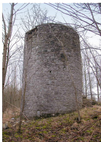
Illu 1 - Tour-réservoir – vue côté nord
