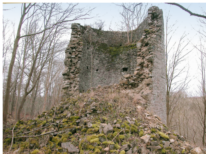
Illu 3 - Tour-réservoir – vue côté sud
