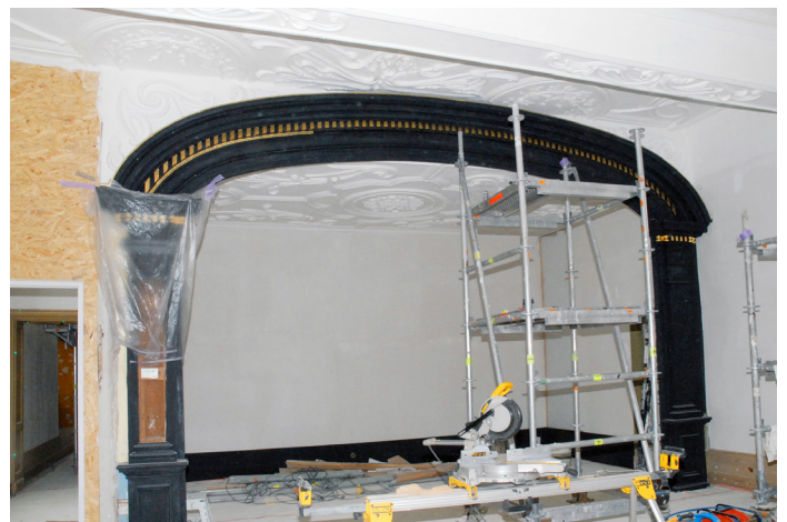
Chambre du comte de Marchin – Restauration des décors en cours – août 2015
