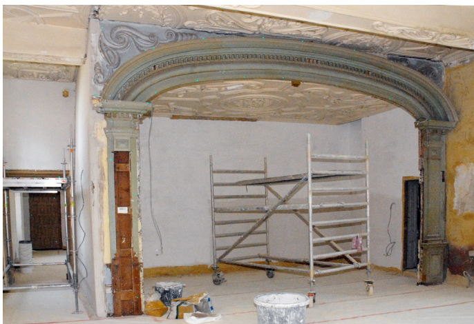
Chambre du comte de Marchin – Etat avant restauration des décors – mai 2015
