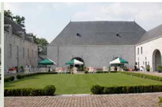
Cour de la 1 ère ferme, après restauration
